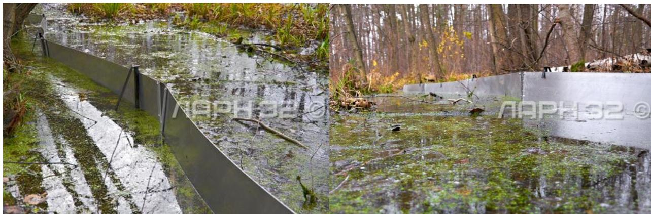
Каждая секция бона состоит из частей, соединенных гибким элементом. Секции болотного бона «БНБ» выполнены из искробезопасного алюминиевого сплава и соединяются между собой с помощью **S-образных** замков ASTM.
