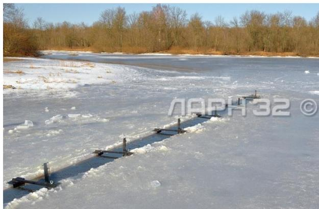
**Боны «БНз»** устанавливаются в предварительно подготовленную ледовую прорезь. Нижняя часть бона опускается ниже на 250 мм нижней кромки льда и служит барьером для пятна разлива нефтепродукта.
